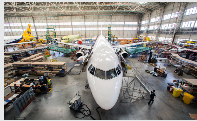
Největší česká oprava letadel. Ohromný hangár pro údržbu a opravy letadel v Mošnově vznikl v roce 1993 a zaměstnává téměř 300 pracovníků.
